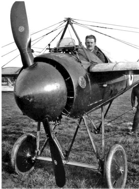
Fig.4a. Morane-Saulnier Type N-flyet der kunne fyre sine skudsalver af gennem propellen uden samtidig at "klippe den af"; udviklet af Roland Garros under 1. Verdenskrig. Man kunne således skyde til måls med selve flyet ved blot at pege næsen den rigtige vej. – Fransk Wikipedia.
